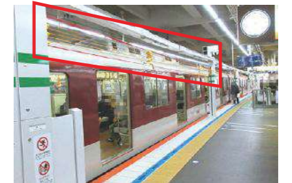
ロープ上昇時の状態
