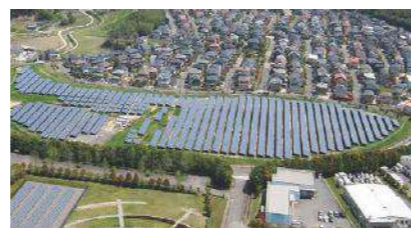
近鉄大分高江ソーラー発電所
