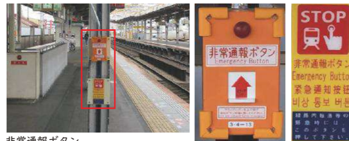
非常通報ボタン
