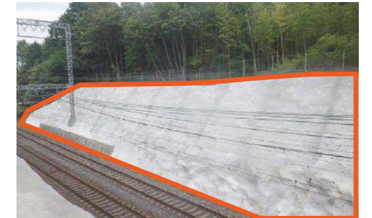
法面補強（三本松～赤目口間）
