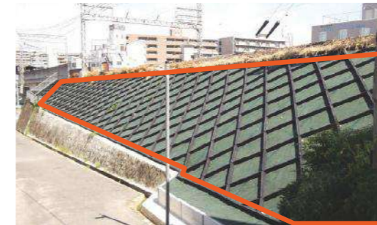
法面補強（東生駒～富雄間）
