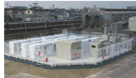
大規模蓄電池(東花園変電所)
