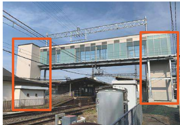
布忍駅 エレベーター
