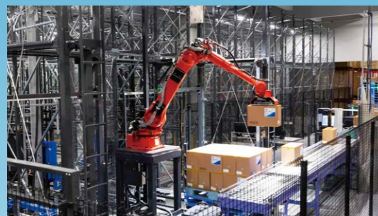
パレット自動倉庫
