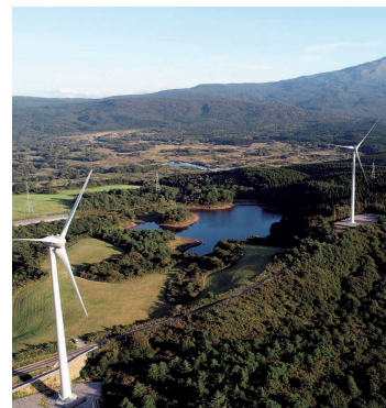
にかほ第二風力発電所 （4万kW・秋田県）
