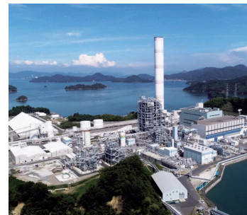
大崎クールジェン（広島県） （酸素吹IGCC実証試験発電所）
