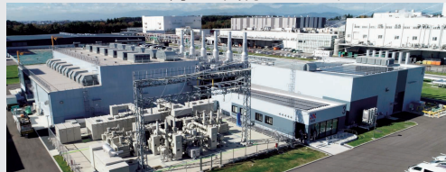
清原スマートエネルギーセンター
