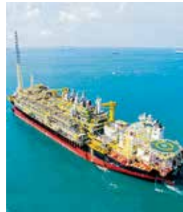
FPSO事業(ブラジル)
