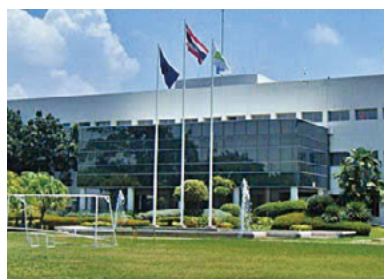
太陽光発電設備を導入した工場
