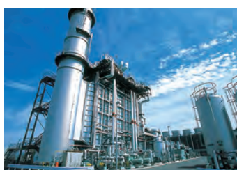
Tokyo Gas Baypower Co., Ltd.
