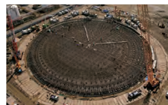
Niihama LNG Terminal
