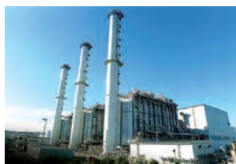
Ohgishima Power Co., Ltd.
