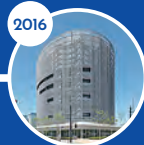
豊洲スマートエネルギーセンター
