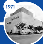
旧新宿地域 冷暖房センター
