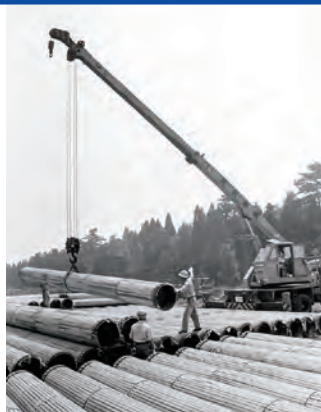
千葉幹線工事
