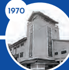
蔵前国技館 初的气体冷暖房システム
