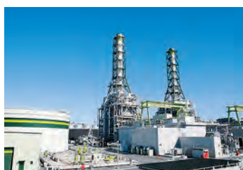
川崎天然ガス発電
