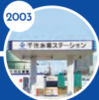
水素ステーション
