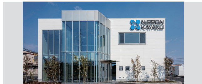
福山工場の品質管理棟
