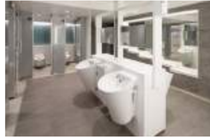
京橋駅(中央)トイレ(京阪電気鉄道)
