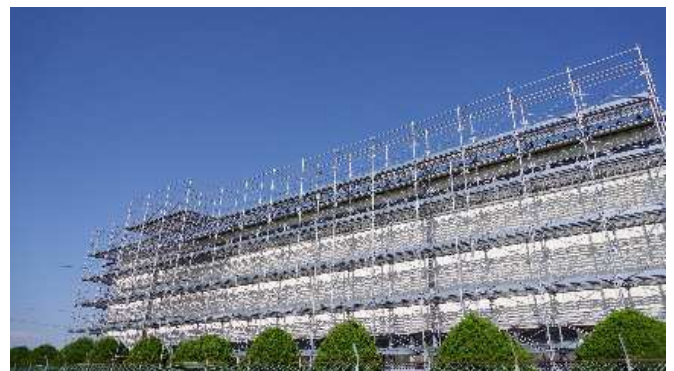
当社が製造した次世代足場「SPS(サイレント・パワー・システム)」の施工例
