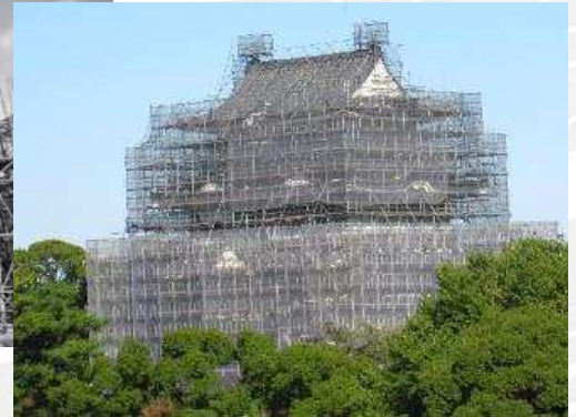
2015年 小田原城耐震工事
