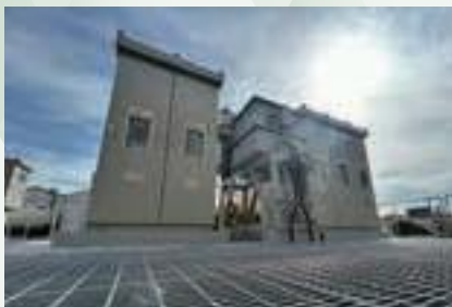
特高受変電設備
