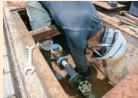
給水装置修繕
