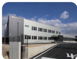
フルサト工業 新滋賀工場
