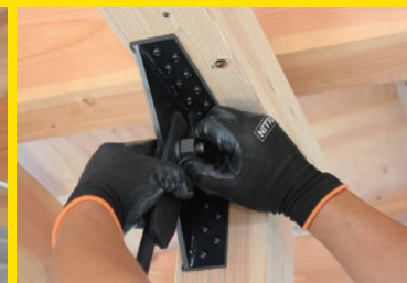
ビスとボルト締めによる簡単施工
