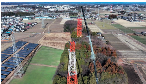
高経年化した鉄塔の更新工事
