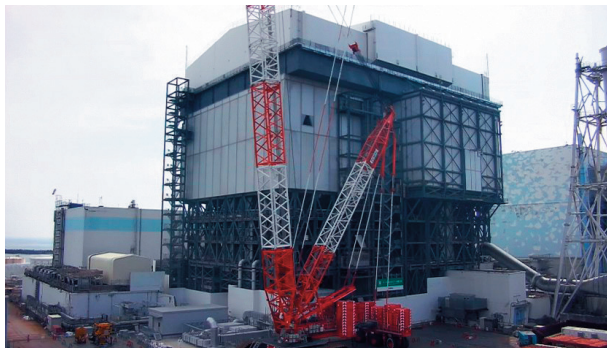
福島第一原子力発電所1号機において大型カバーを設置
