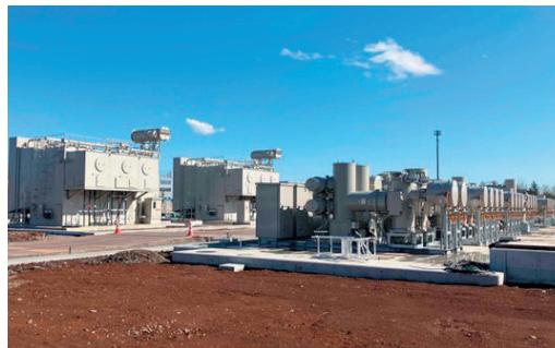
大規模供給に向けた変電所新設工事
