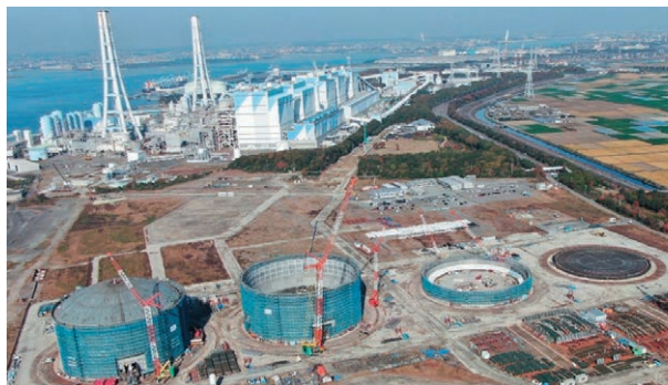
碧南火力発電所（愛知県）にて商用アンモニアタンクを建設
