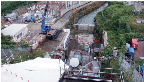
内山発電所（神奈川県）のリプレース工事
