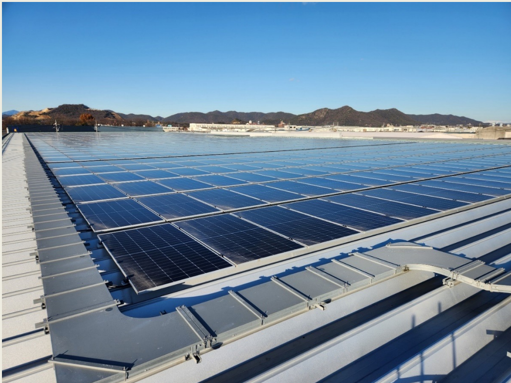
岐阜新・第1工場 定格出力：437.5kWパネル容量：550 Wパネル数量：894 枚
