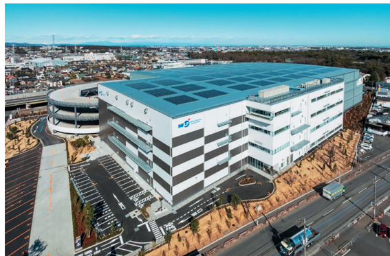
「三井不動産ロジスティクスパーク入間1」(埼玉県入間市)
