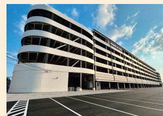
北大阪トラックターミナル7号棟
