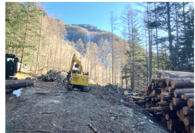
ヤードの準備工事（樹木の伐採）
