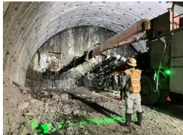
長島トンネル 本坑掘削
