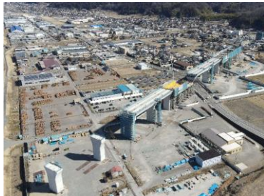
阿島北高架橋
