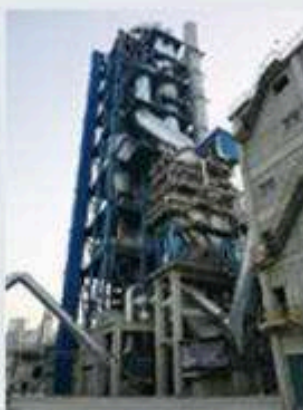
セメントプラント 排熱発電設備
