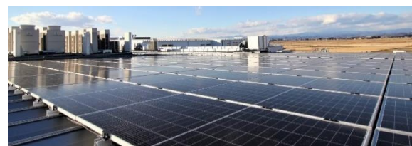
脱炭素社会の実現へ。省エネ型自然冷媒の冷凍冷蔵設備導入を進めています。
