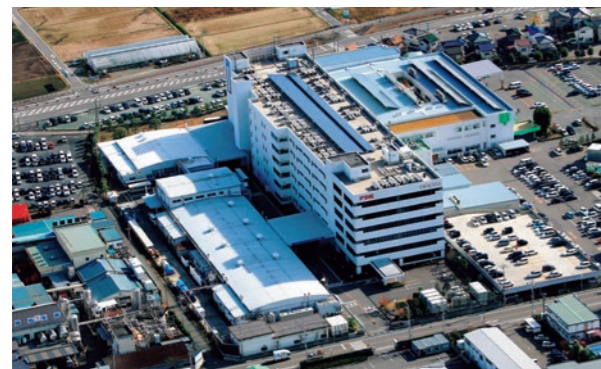
高崎工場(群馬県)に設置したソーラーパネル
