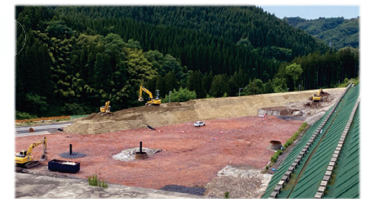
北陸環境サービスの最終処分場
