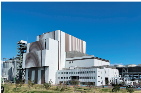
バイオマス発電プラント
