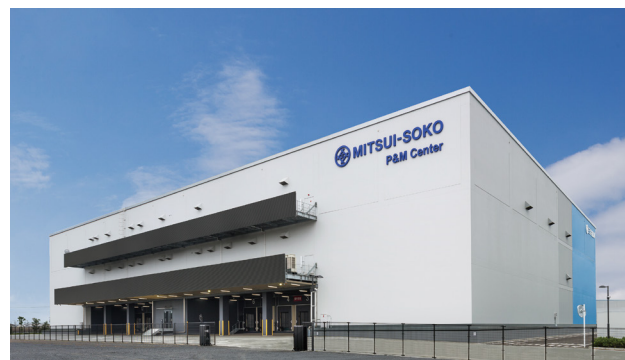
関東P&MセンターA棟
