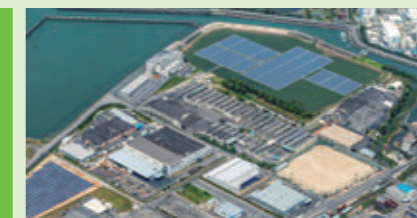
Kinuura Plant (Substrate Holding Mat)
