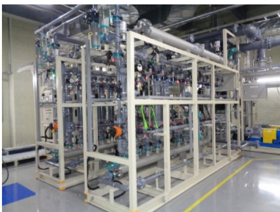
再生水処理装置（NCDK富士吉田工場）
