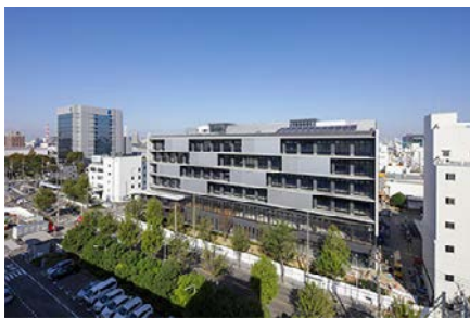
新事務・厚生棟
