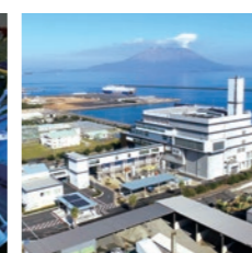
鹿児島市南部清掃工場向け ごみ焼却施設・ バイオガス施設
