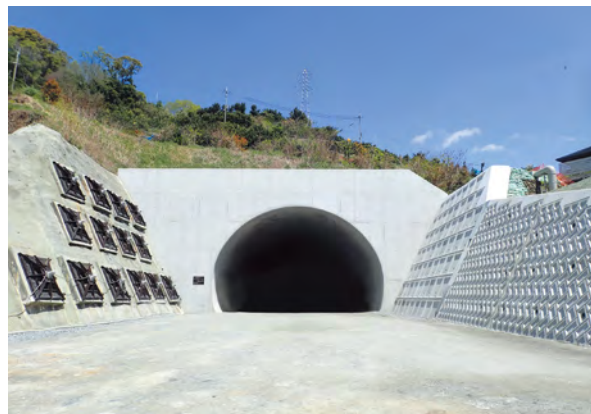
有田海南道路5号トンネル工事
