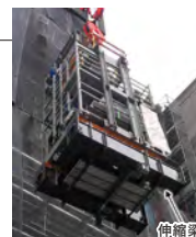
機械室ユニット
