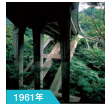
1961年 箱根バイパス天狗橋
