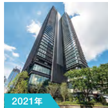
2021年 常盤橋タワー
