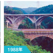
1988年 老ノ坂亀岡バイパス橋
