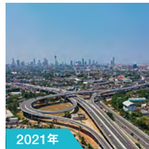
2021年 ケラニ河新橋建設工事
