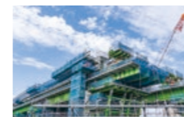
京阪電鉄 淀川東高架橋
