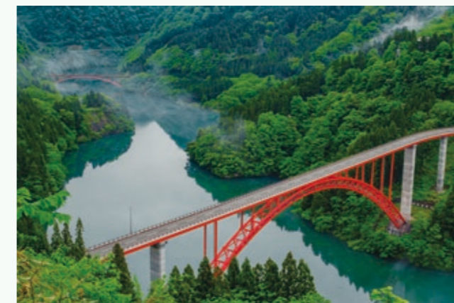
利賀大橋 / 富山県南砺市
