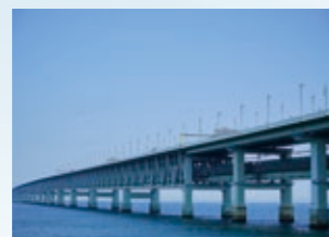
関西国際空港連絡橋 (スカイゲートブリッジR)
