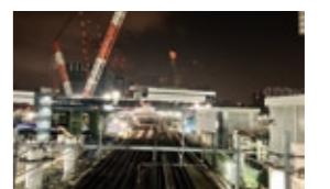
品川駅構内環状4号線交差部新設
