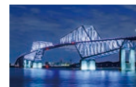
東京ゲートブリッジ
