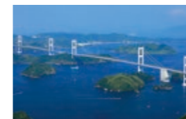
来島海峡大橋
