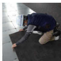
タイルカーペット施工の様子
