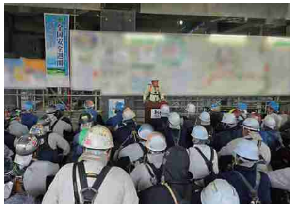
社長安全パトロールにおける現場朝礼での訓示
