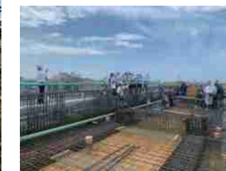
H-BAコンクリート打設の様子
