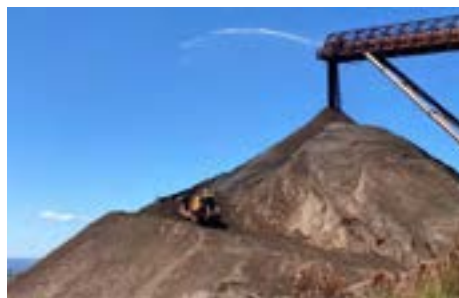
鉱山でストックパイルオペレーションを行う遠隔操作ブルドーザー
