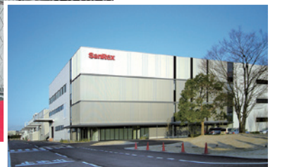
滋賀工場新棟竣工(2014年)
