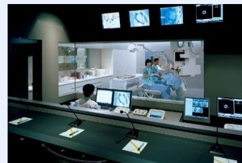
カテーテル手術のシミュレーション室 四方の壁と天井に鉛板を仕込むことで、周囲に X線が漏れることを防ぐ
