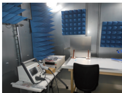
シールドルーム内での静電気試験環境
