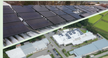
太陽光パネルの設置 (ロジテックINAソリューションズ伊那工場)
