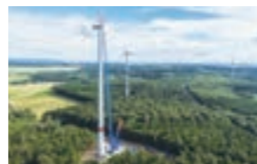
風力発電設備組み立て
