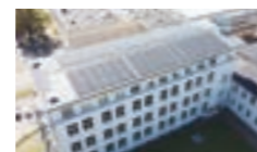
太陽光パネルの設置 (Dinglerstraße事務所)
