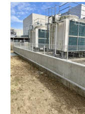
リコーインダストリー東北事業所 非常用発電機防水壁
