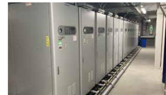
塗装ボイラーを電氣式に変更した設備
