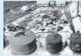
昭和石油(株)室蘭製油所に建設された受注第1号タンク
