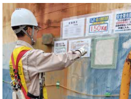
タンクメンテナンス現場における安全パトロール
