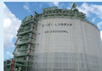
世界最大規模のLNGタンク
