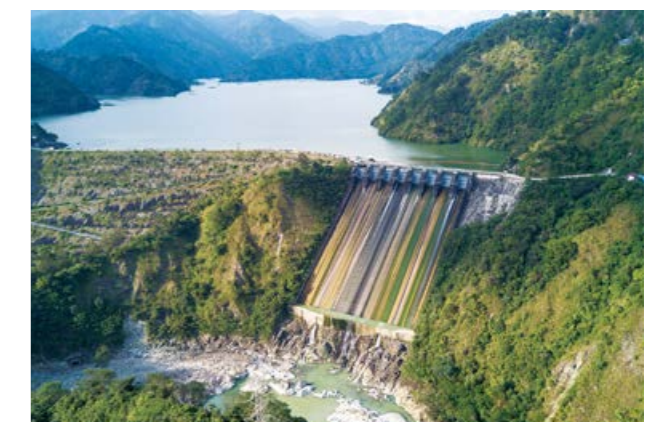
水力発電所全景
