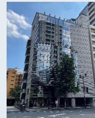
BIZIA Kojimachi Building
