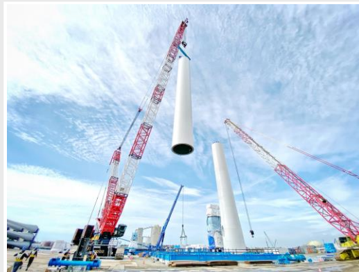
クレーン（洋上風車組み立て）
