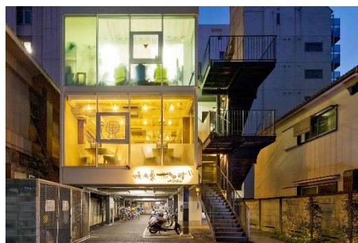
フィル・パーク三鷹（竣工 2010 年 8 月）
