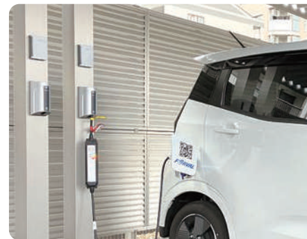
普通充電設備8台設置
