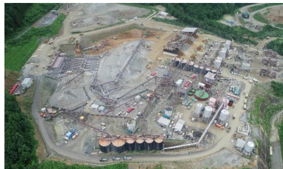
写真：「成瀬ダム原石山採取工事」骨材製造プラント
