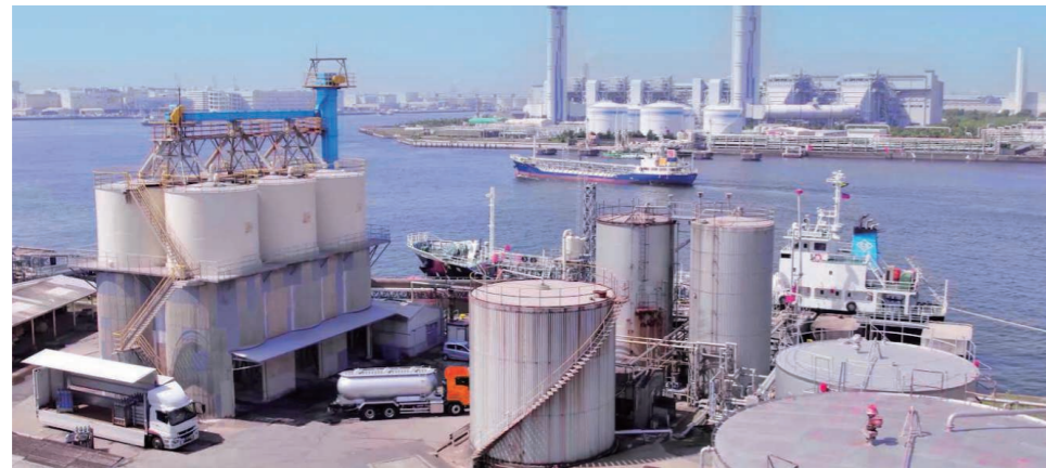
川崎化成品油槽所
