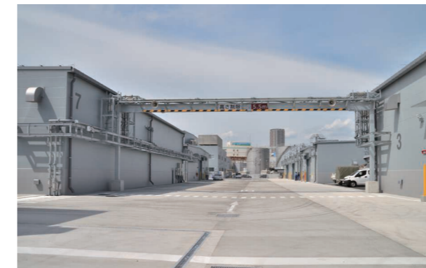
神奈川埠頭倉庫営業所
