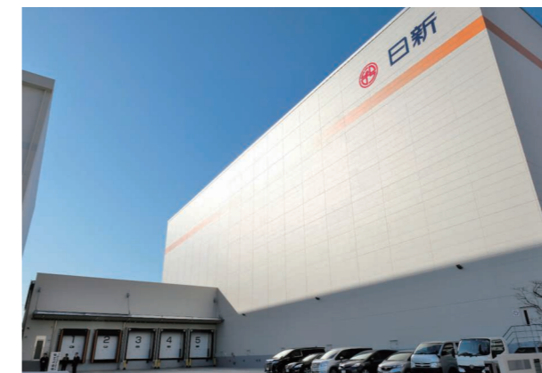
摩耶冷蔵センター
