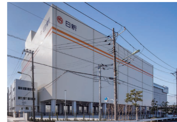
平和島冷蔵物流センター
