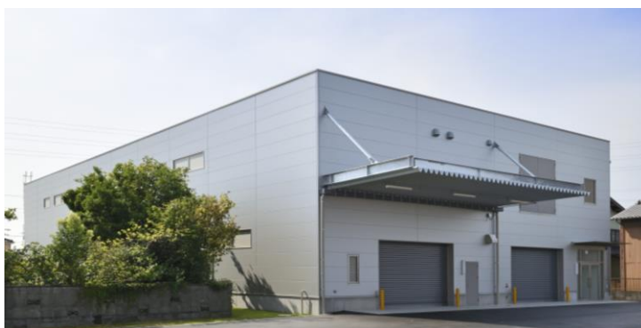
第2工場外観（正面）
