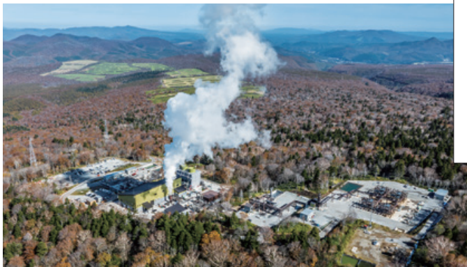
<安比地熱発電所全景>
