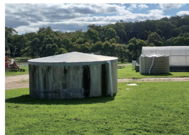
Jurlique 雨水を貯めておく難燃性タンク
