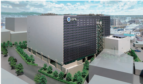
BML総合研究所新棟(埼玉県川越市) 竣工:2024年8月予定 稼働:2025年1月予定
